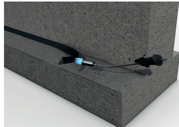
Kerabit Bituminen holkkalistan avulla kulmien loivennukset voidaan toteuttaa kustannustehokkaasti entistä nopeammin, sujuvammin ja varmemmin.
